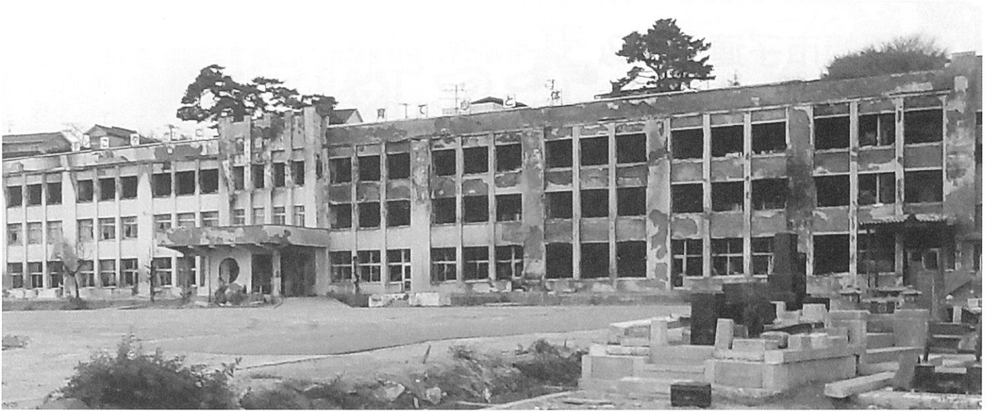
▲津波が押し寄せ、流れてきたガソリンに引火し、黒こげになった石巻市立門脇小学校
